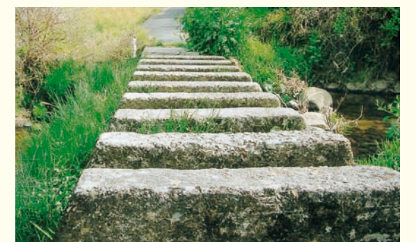
地元の人が「ピョンピョン橋」と呼んでいる橋
