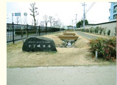
歩道に沿って造られた水路
