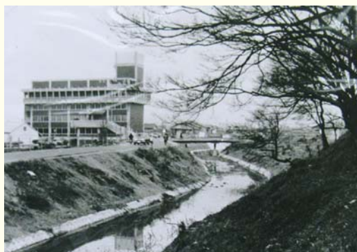
元茨木川堤(昭和43年頃)
