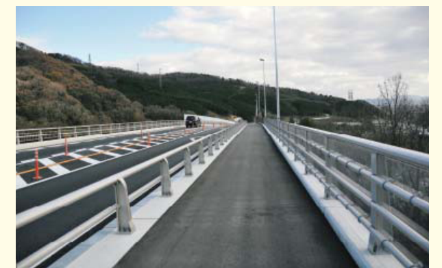
府道茨木亀岡線付替道路にある桑原大橋の橋上
