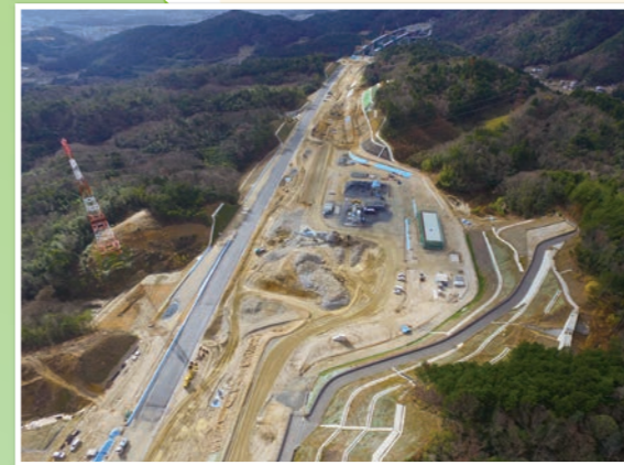
⑨茨木北IC(仮称)建設現場(NEXCO西日本提供)
