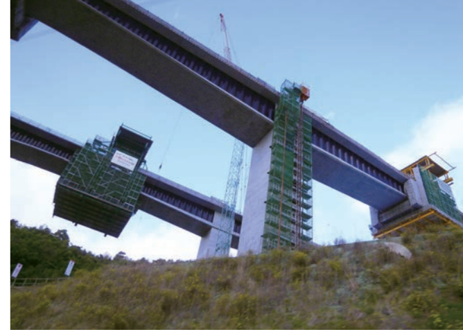
⑧佐保川橋工事現場
