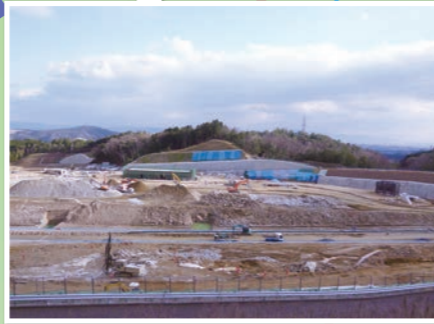
茨木北IC(仮称)建設現場見学ポイントから
